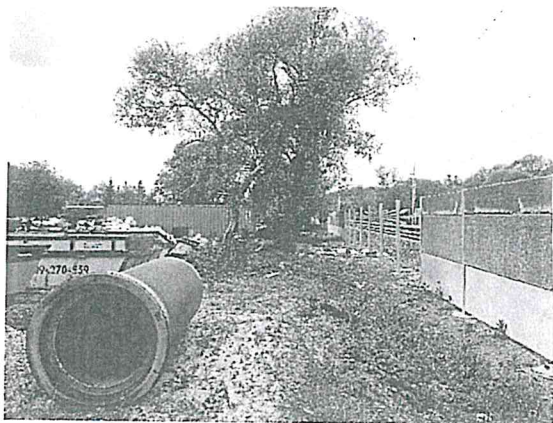
vasúti zajvédőfal építés közben
