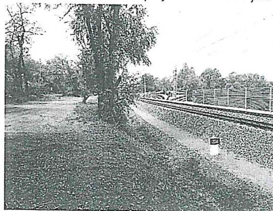
Budapest–Hatvan vasúti pálya a telekbelső felől
