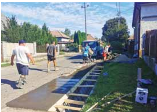
Vízvezető árok felújítása a Jókai utcában
