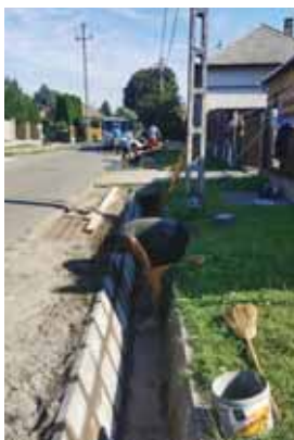
Vízvezető árok felújítása a Jókai utcában
