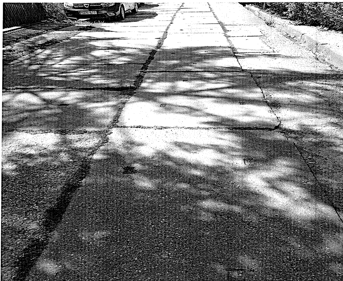
Meglévő burkolat árokkal
