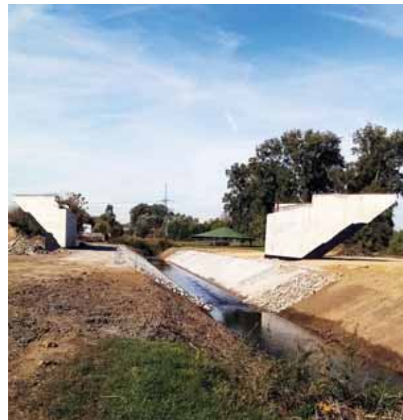
A Rákos patak feletti felüljáró tartópillére és a vízelvezetési munkák
