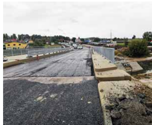
A felüljáró aszfaltozása
