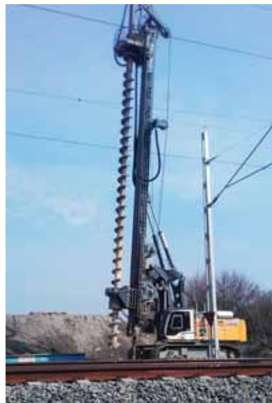
Az első kapavágások és cölöpölés a vonatsínek mellett
