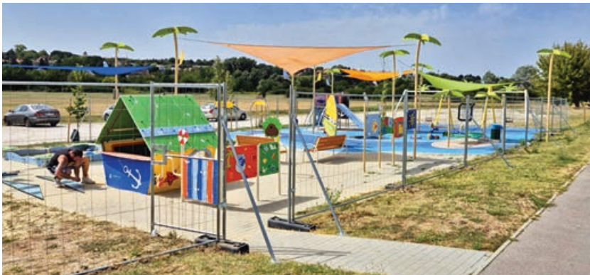
A játszótér körbekerítése a Topolyosban
