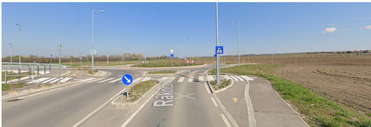
Rákóczi út négyágú körforgalma és az önálló kerékpársáv kezdete a Pesti út irányába (Google Utcakép)
