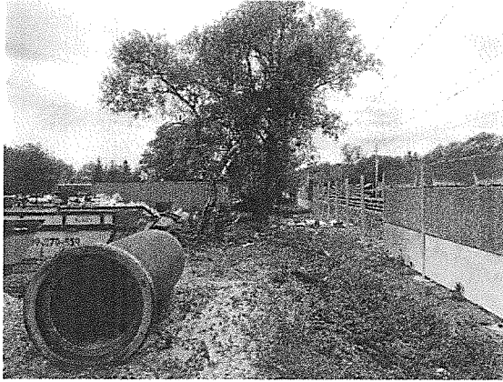
vasúti zajvédőfal építés közben
