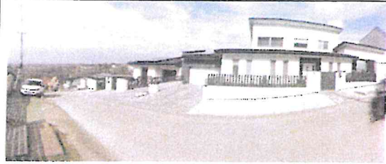
3673 hrsz-ú telek homlokzata
