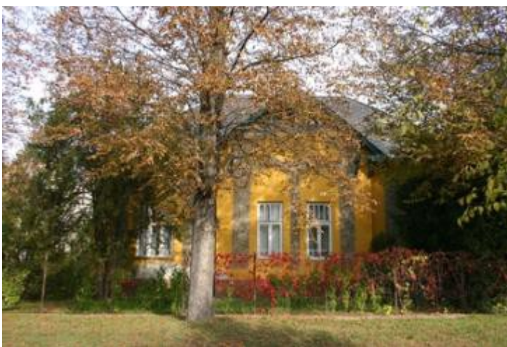
lakóház-villaépület Kölcsey u.14. (hrsz:2515)
