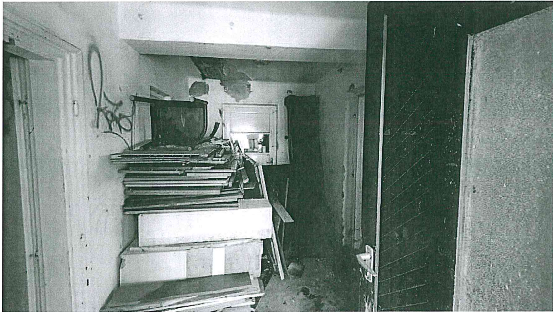
Előtér - mennyezeti ázásnyomokkal
