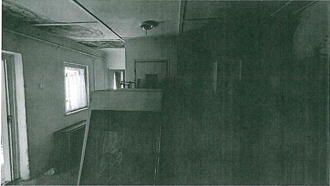
Öltöző – mennyezeti és oldalfali ázásnyomokkal
