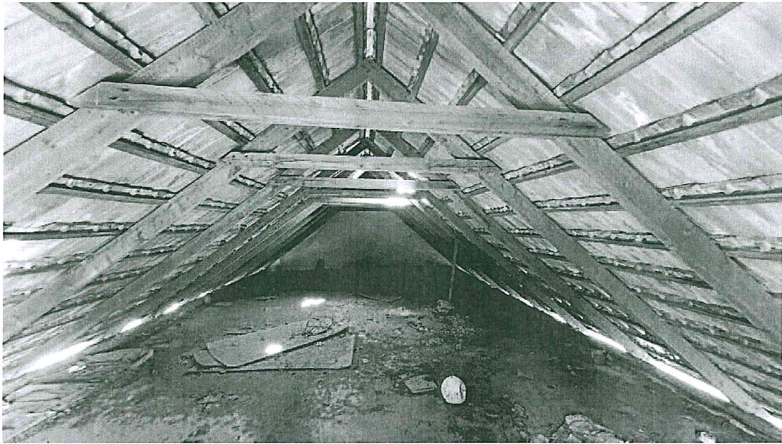
A tornatermi rész padlásteré, jó állapotú faszerkezettel, de már hézagos héjazattal
