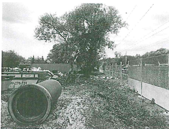
vasúti zajvédőfal építés közben
