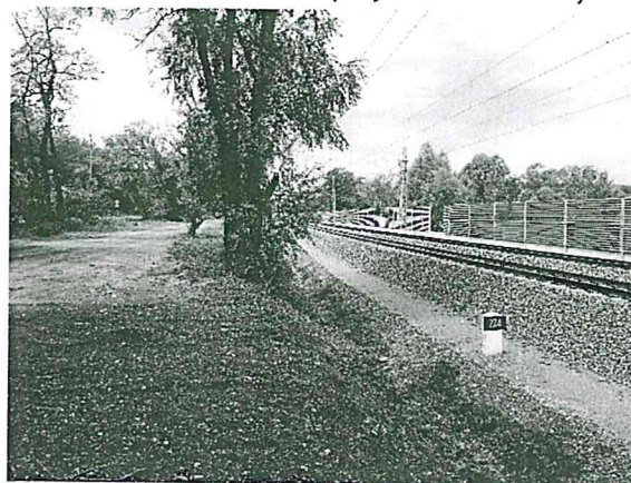
Budapest–Hatvan vasúti pálya a telekbelső felől
