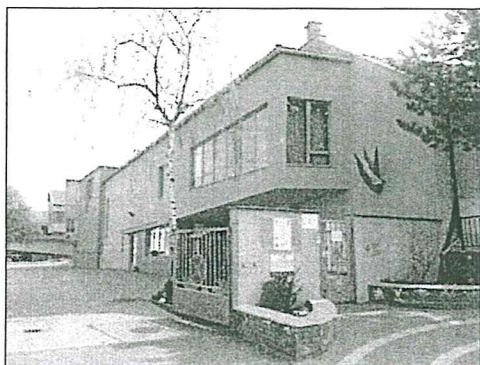
Szomszédos óvoda épület
