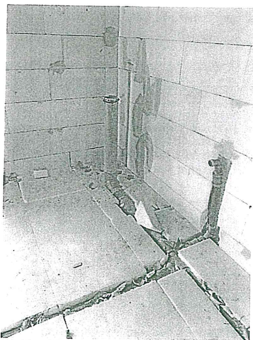
24. fénykép: Szennyvízvezetékek elhelyezve
