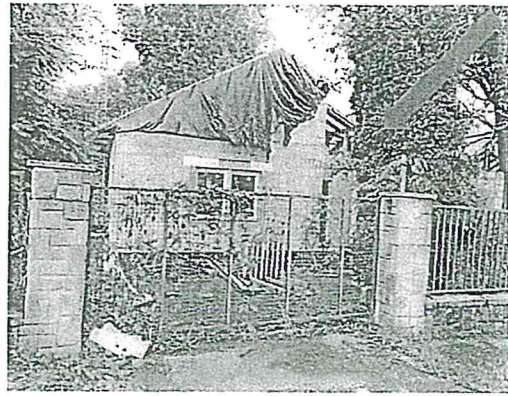
2. fénykép: Utcai homlokzat
