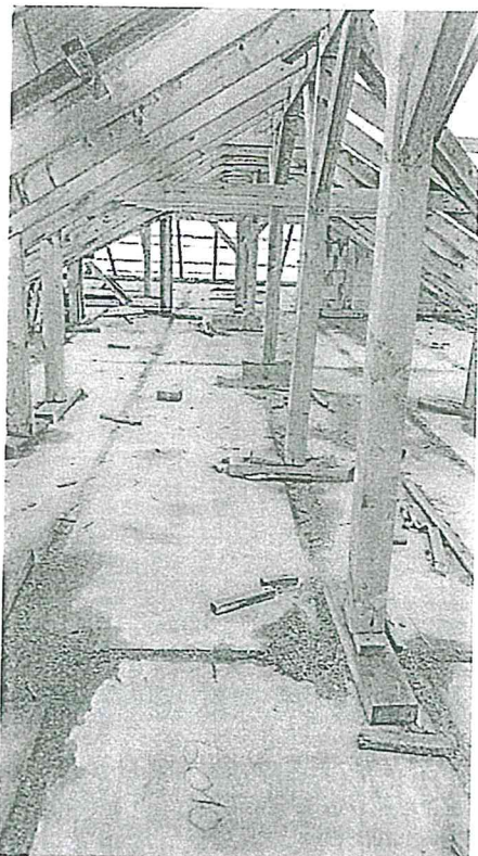
32. fénykép: A fedélszék logikátlan oszlophelyezése
