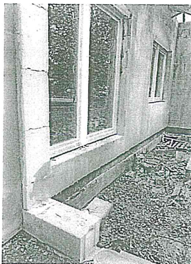
13. fénykép: Befejezetlen lábázat
