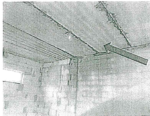
21. fénykép: Körüreges pallófödém készült
