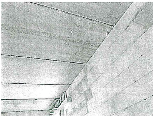
20. fénykép: Körüreges pallófödém készült
