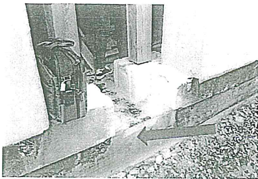
12. fénykép: Félbehagyott lábázat-szigetelés
