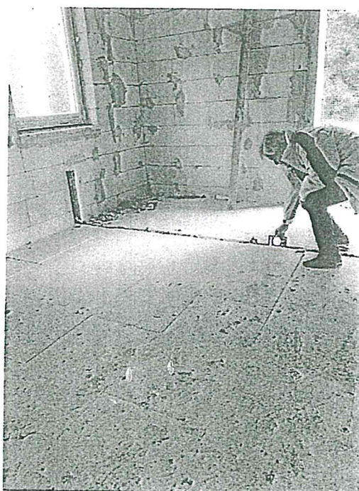
25. fénykép: A vezeték lejtésének ellenőrzése
