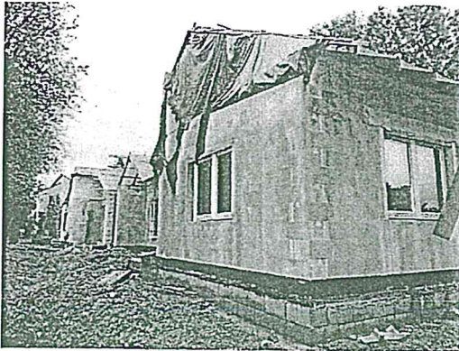
5. fénykép: Az épület délről nézve
