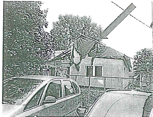
4. fénykép: Utcai homlokzat
