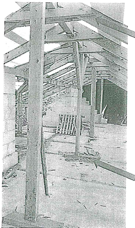
33. fénykép: A fedélszék logikátlan oszlophelyezése
