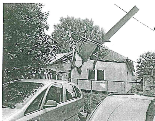
4. fénykép: Utcai homlokzat
