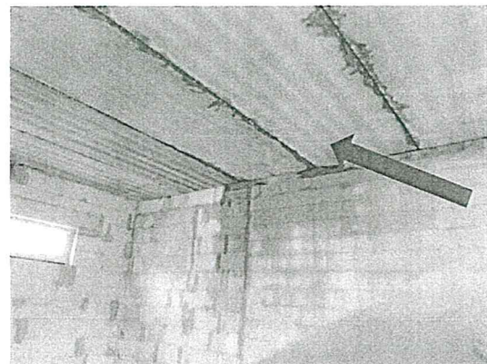
21. fénykép: Körüreges pallófödém készült
