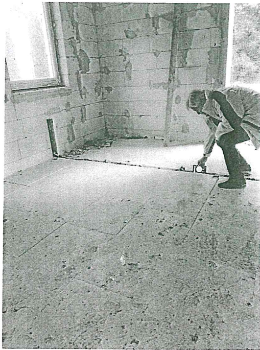
25. fénykép: A vezeték lejtésének ellenőrzése
