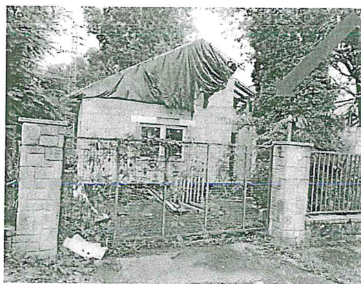
2. fénykép: Utcai homlokzat
