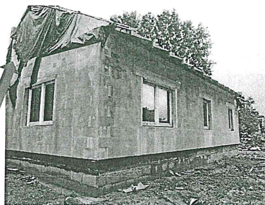
6. fénykép: Déli homlokzat, védőnői rész.
