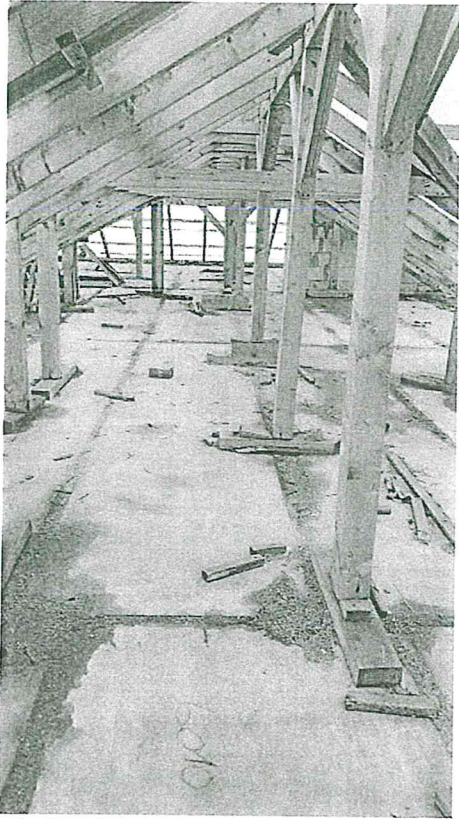
32. fénykép: A fedélszék logikátlan oszlophelyezése
