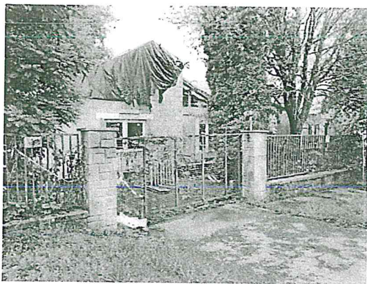
1. fénykép: Utcai homlokzat
