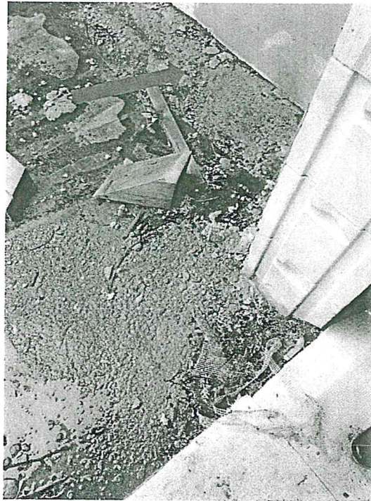
15. fénykép: A lábazati fal alatti betonozás kialakítása
