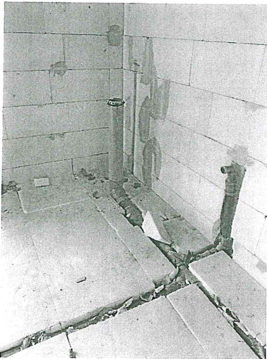
24. fénykép: Szennyvízvezetékek elhelyezve
