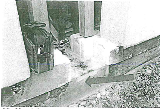
12. fénykép: Félbehagyott lábazat-szigetelés
