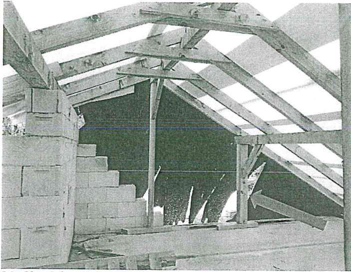
36. fénykép: A fedélszék és a széthasadt védőfólia
