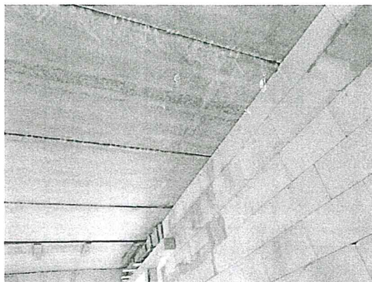
20. fénykép: Körüreges pallófödém készült
