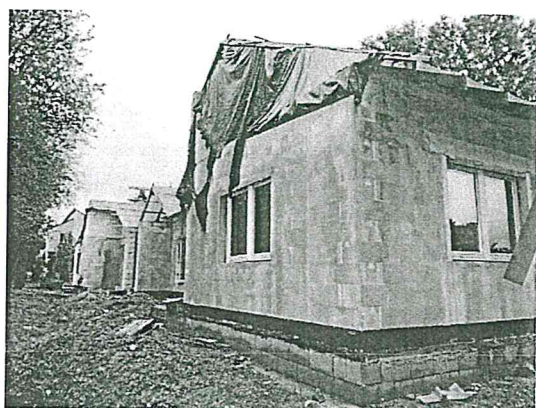
5. fénykép: Az épület délről nézve
