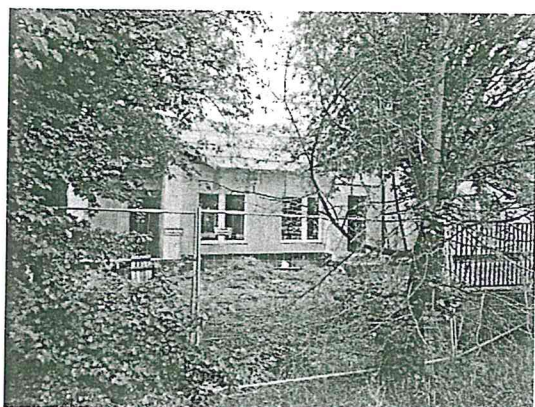
3. fénykép: Utcai homlokzat
