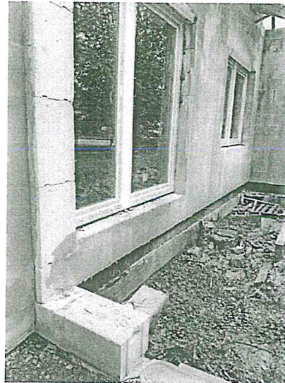
13. fénykép: Befejezetlen lábazat
