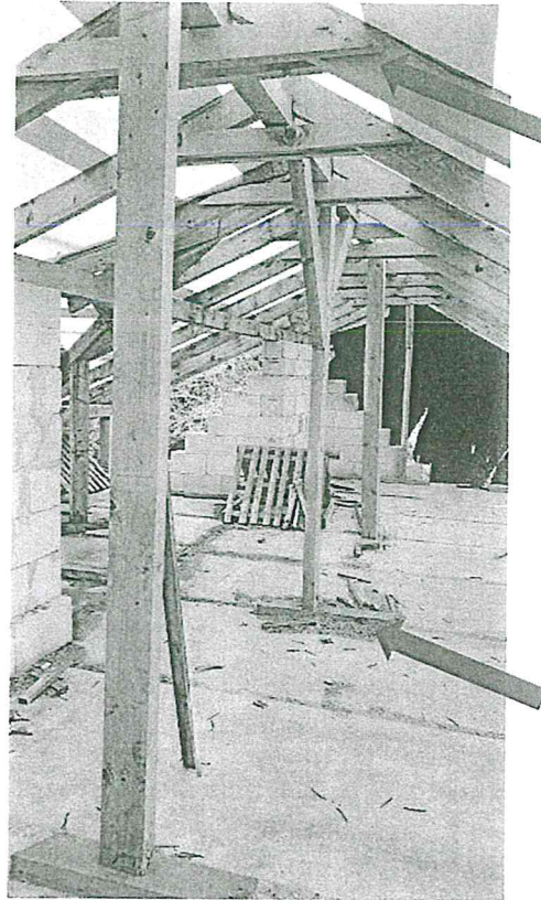
33. fénykép: A fedélszék logikátlan oszlophelyezése
