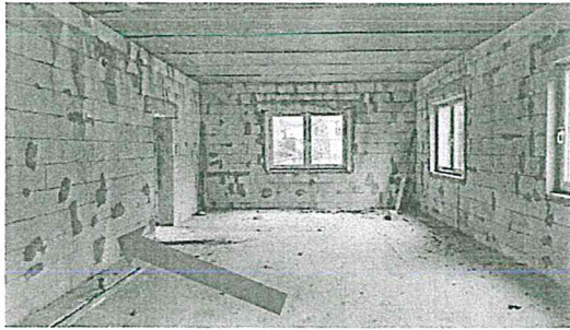
16. fénykép: A belső teherhordó fal is Porfix elemekkel készült
