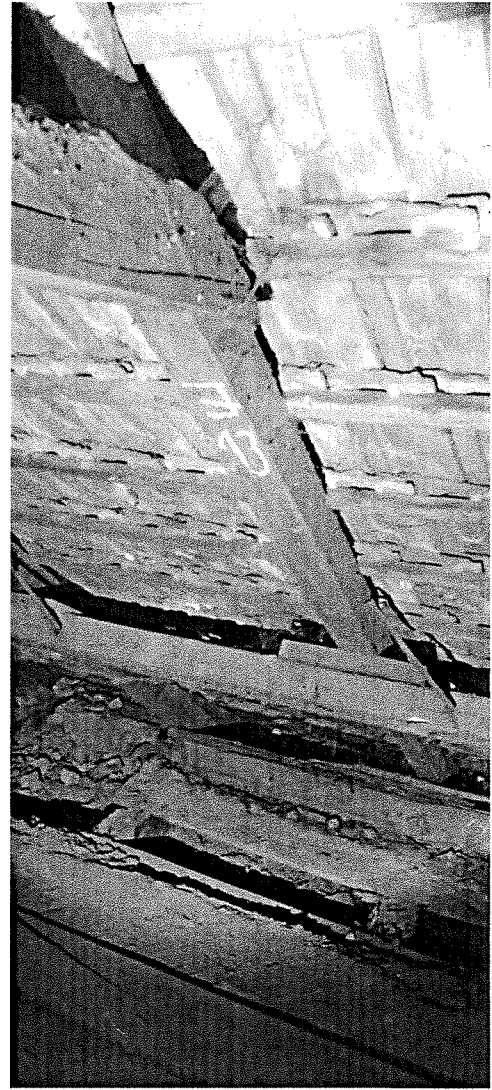
8. kép utólag beépített körömszelemen
