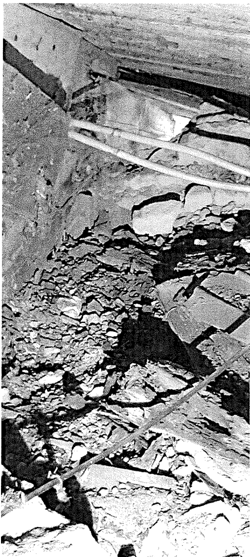
4. kép teljes keresztmetszetben korhadt sárggerenda
