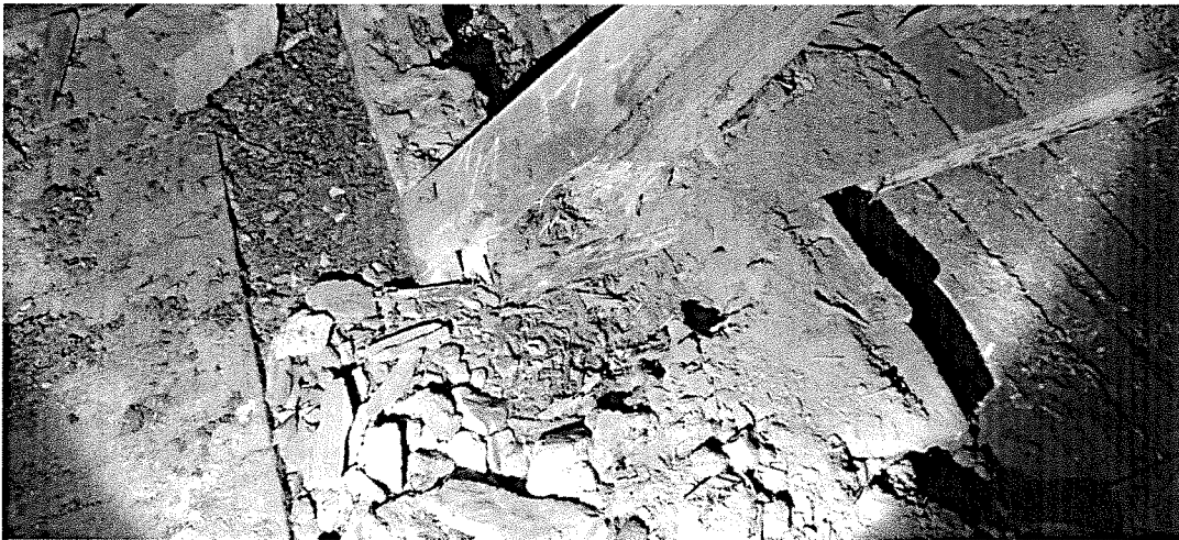
2. kép teljes keresztmetszetben károsodott szarufa vége
