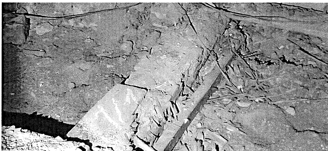
9. kép teljes keresztmetszetben rovakárosított födémgerenda
