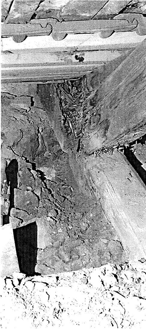
7. kép teljes keresztmetszetű gombakárosított csomópont
