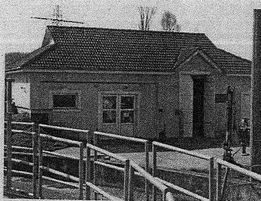
Az üzemviteli épület(1)
