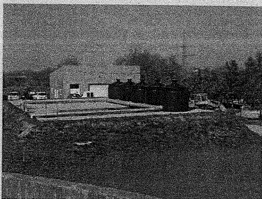
Havária véstároló műtárgy (11)
