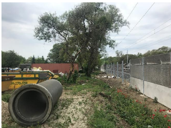
vasúti zajvédőfal építés közben
