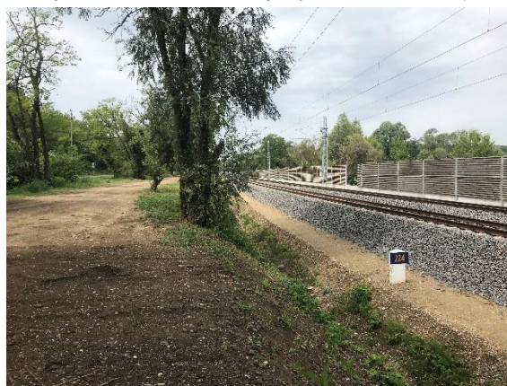
Budapest–Hatvan vasúti pálya a telekbelső felől
